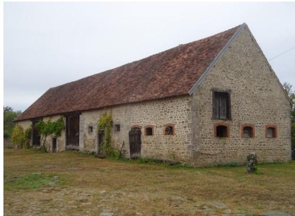
A la Révolution, la commanderie est vendue et transformée en bâtiment agricole. La chapelle a été divisée en 2 niveaux par la construction d'un plancher soutenu par des poutres encastrées dans les murs. Mais lorsque le plancher a été retiré, la stabilité de l'édifice en a souffert et il a fallu la consolider par des IPN. Le toit est en très mauvais état et pour des raisons de sécurité évidentes, nous ne rentrerons pas dans la chapelle, nous ne pourrons jeter qu'un coup d'œil par la porte.
