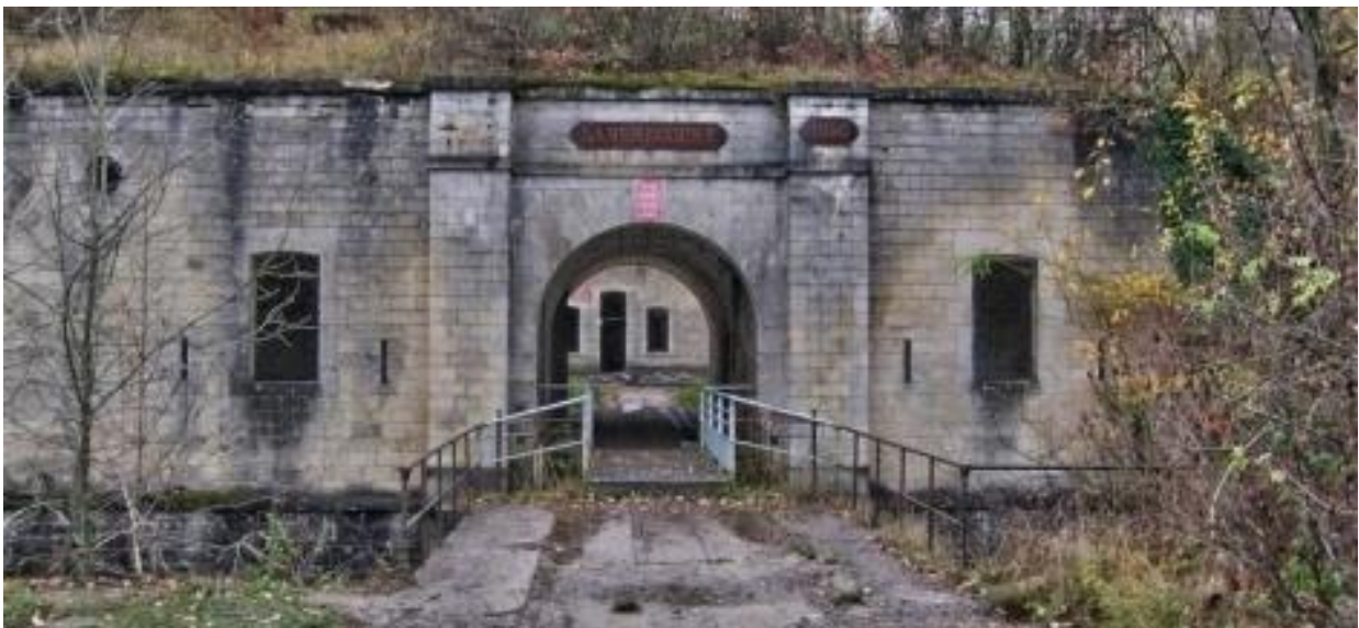
Fort de Landrecourt.
