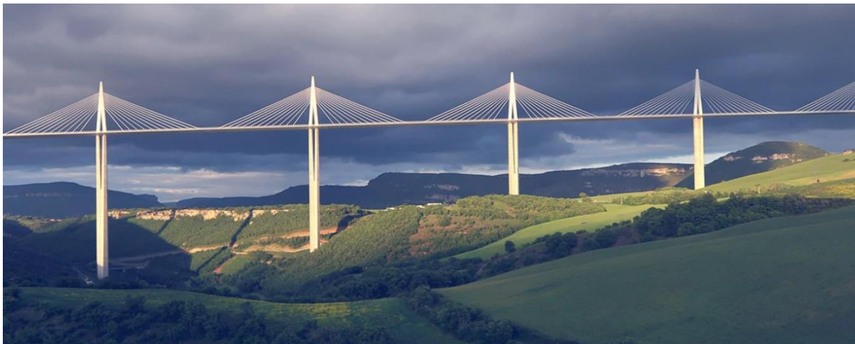
Viaduc de Millau (décembre 2001-décembre 2004)
