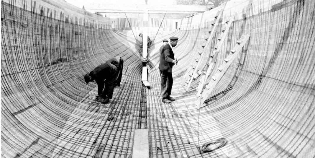
Ferraillage d'une coque de navire. 2
