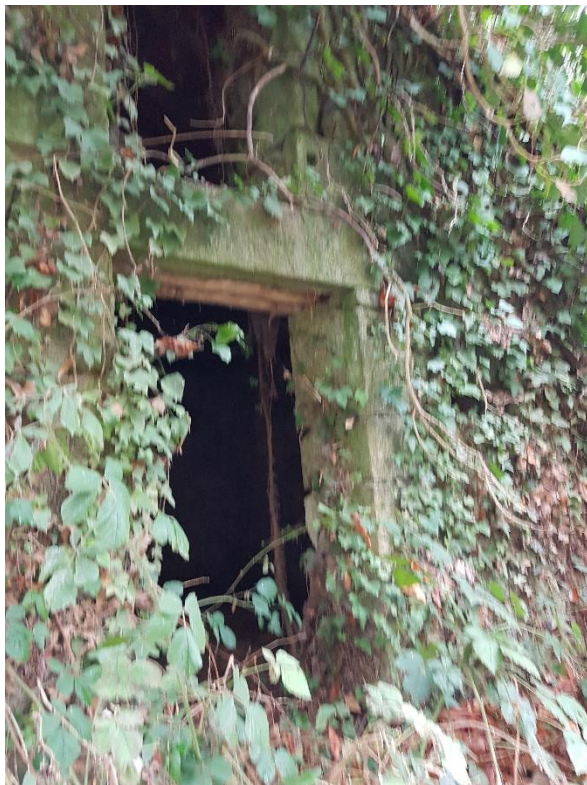
Les ouvertures de l'ancien moulin.
