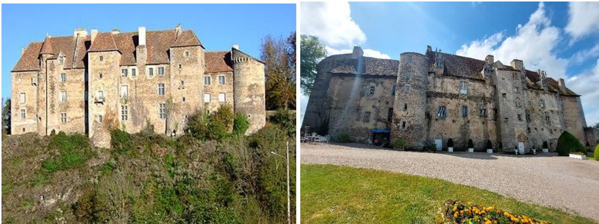
Château de Boussac coté vallée de la Petite Creuse et côté cour intérieure.
