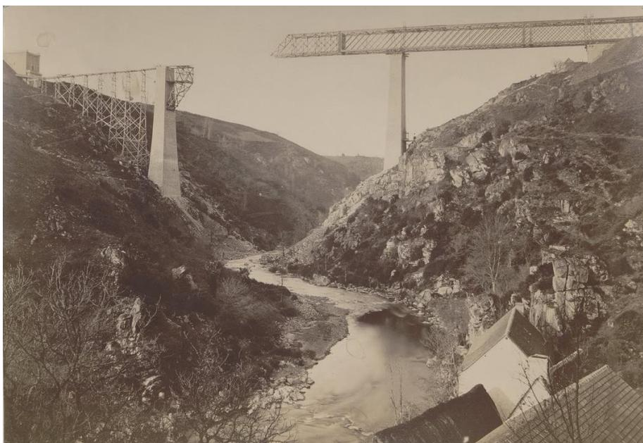
Quant au tablier, fait d'un assemblage de poutrelles métalliques rivetées, comme la tour Eiffel, il fut réalisé par tronçons sur le bord du plateau côté Evaux, et poussé au fur et à mesure sur la culée, puis au-dessus du vide,
