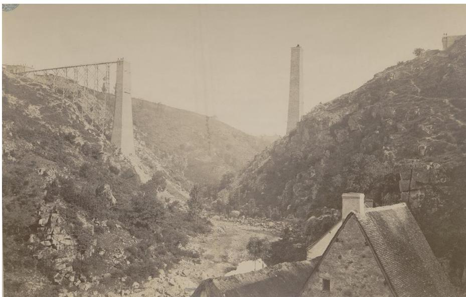
On n'a pas échafaudé autour des piles, mais en créant des chemins d'accès sur poteaux et poutres de bois, à l'horizontale, depuis le flanc de la vallée, par un empilement successif de rampes d'accès
