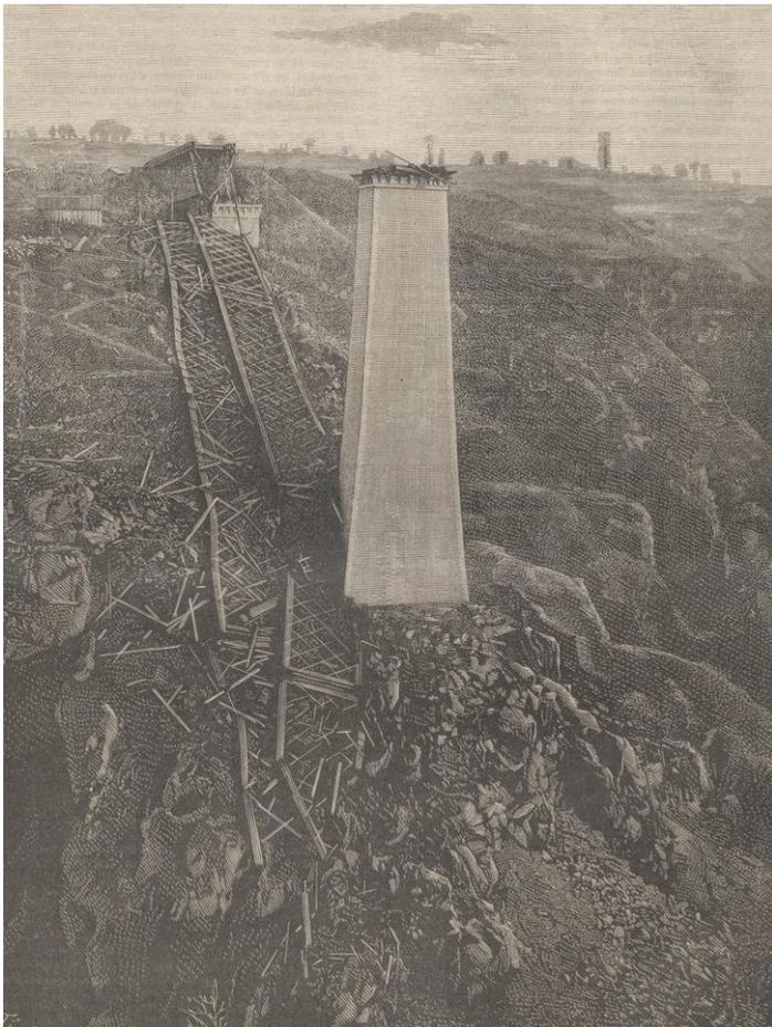
appelle le phénomène de résonance, brisant des poutrelles, provoquant la cassure et la chute.) (Cf. photo)
