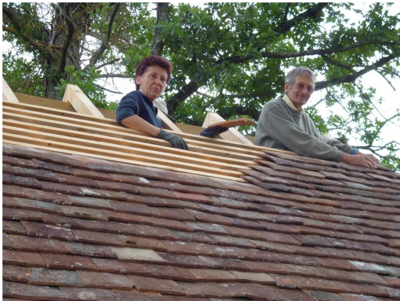
Etape 4 : Couverture en petites tuiles traditionnelles.
