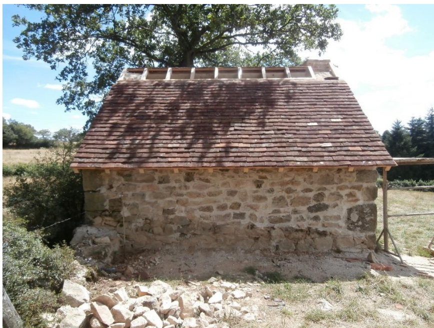
Etape 4 : Couverture en petites tuiles traditionnelles.
