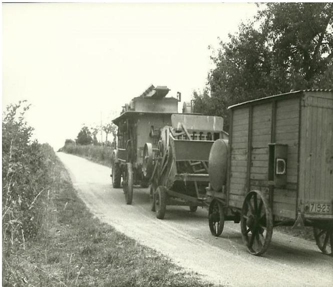
Le convoi de la batteuse se composait du tracteur remorquant la batteuse avec le monte-gerbes dessus, la presse à paille, la remorque dans laquelle on trouvait le réservoir à gazoil, les courroies, les crics et les cales pour stabiliser horizontalement les matériels, la réserve de carburant, l'outillage de dépannage, les pompes à graisses pour la mécanique et les courroies, les tuyaux d'évacuation de la *balle* de paille, etc...
